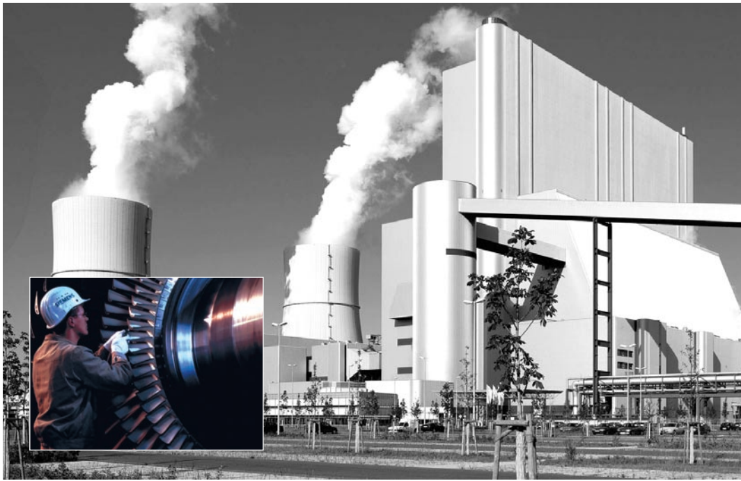
Siemens Power Generation baut Dampfturbinen für Kraftwerke wie etwa den VeAG-Standort Schwarze Pumpe in Garzweiler; Kleines Bild: Prüfung der ersten beiden Schaufelreihen einer SIEMENS-Gasturbine, die mit einer speziellen Hitzeschutzlegierung beschichtet sind
