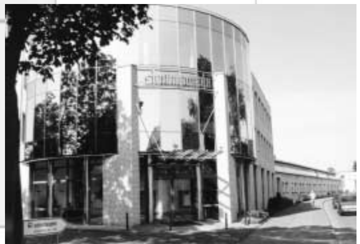
Das Simonswerk in Rheda-Wiedenbrück
