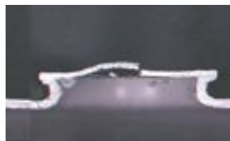
Bild 2: Reißer Photograph 2: Clip-out failure
